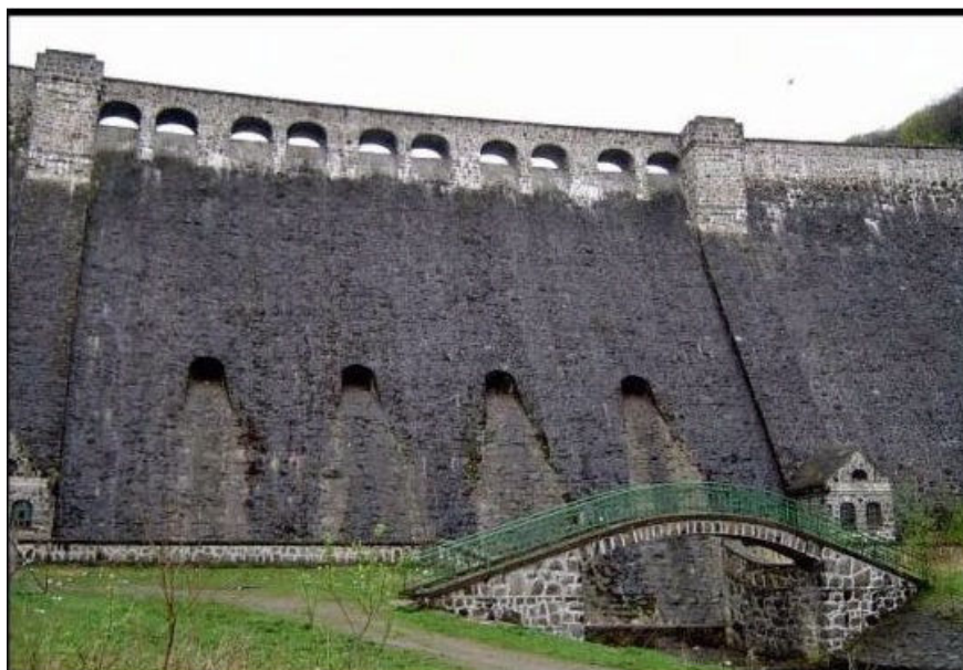
Zapora wodna na Jeziorze Bystrzyckim Zdjęcie nr 1
